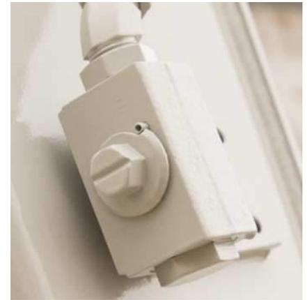
Rubinetti aperti / chiusi all'uscita dell'impianto ausiliario per evitare spillamenti e perdite di pressione in fase di installazione / disinstallazione attrezzature.
